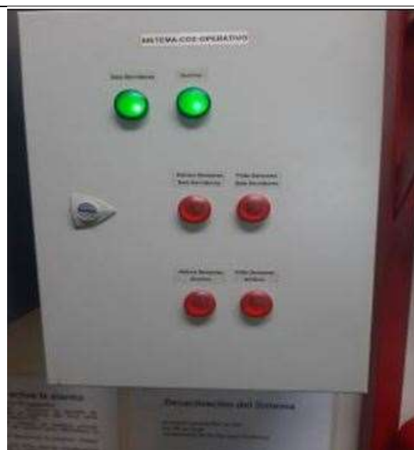
Panel de control del Sistema Fijo CO2
